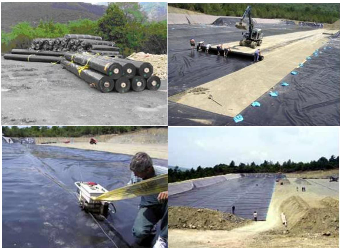
Slika 10. Prikaz izgleda PEHD folija, način postavljanja i zavarivanja
