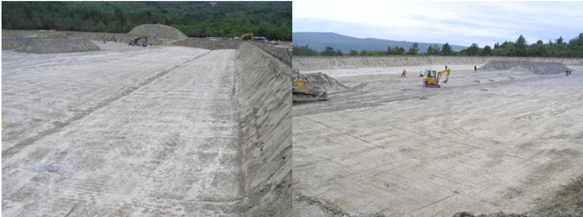
Slika 9. Prikaz izgrađenog mineralnog izolacionog sloja
