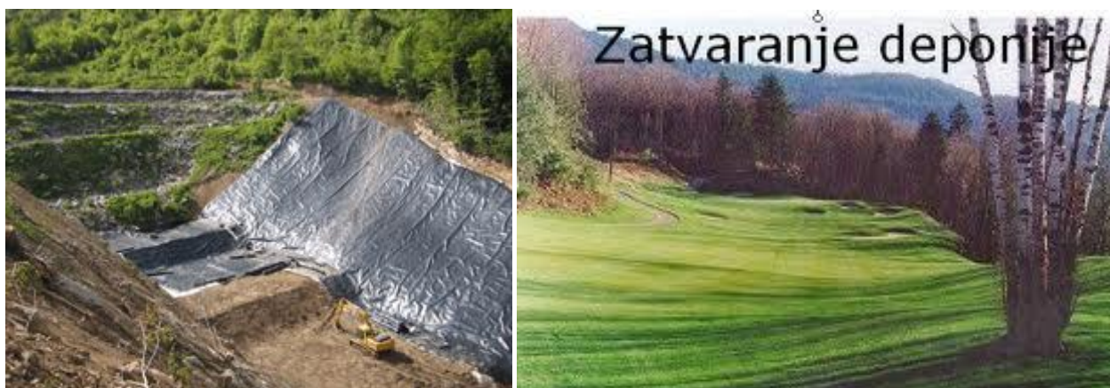
Slika 14. Prikaz načina zatvaranja i završnog izgleda sanitarne deponije, sidrenja PEHD folija
